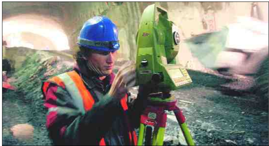
NADZORNIKI SKRBIJO, DA SE BOSTA ROVA ZDRUŽILA PRAVILNO
