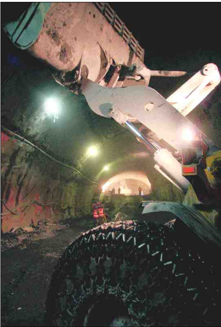
BAGRI ODVAŽAJO PO STO KUBIČNIH METROV ZA VSAK METER PREDORA
