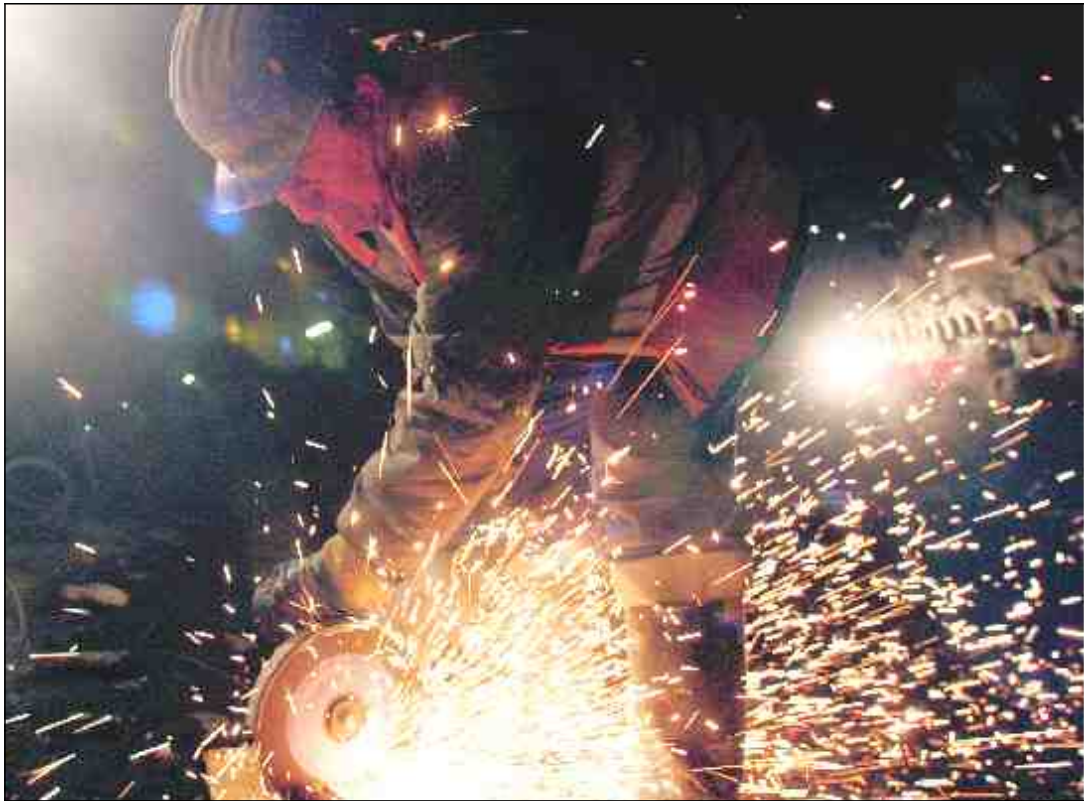
VELIKOST ŽELEZNIH MREŽ PRILAGODIJO NA GRADBIŠČU
